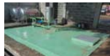
排水処理施設の様子
